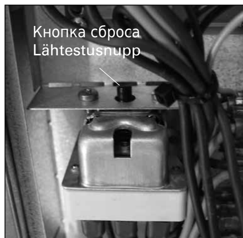
Рис. 3. Защита от перегрева Joonis 3. Ülekuumenemiskaitse
